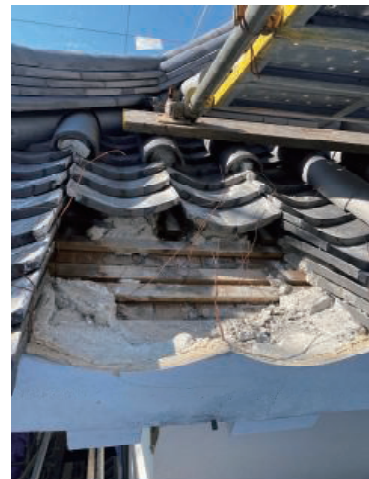
工事中 上重屋根破風尻 瓦取外し
