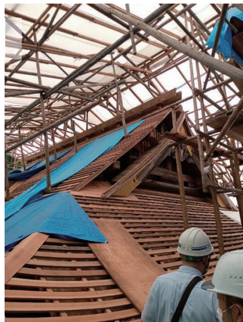
破風際の箕甲となる部分
