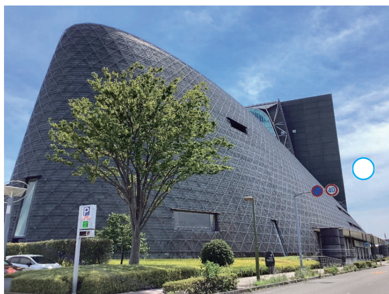
外壁の改修後の三角形状パネル
