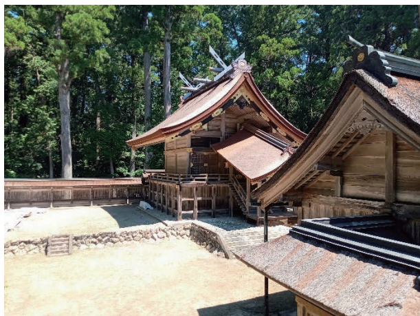
すでに葺き替えが完了している御本殿
