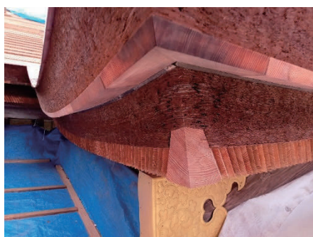
軒先の隅葺き部分 美しく檜皮が重ねられています。
