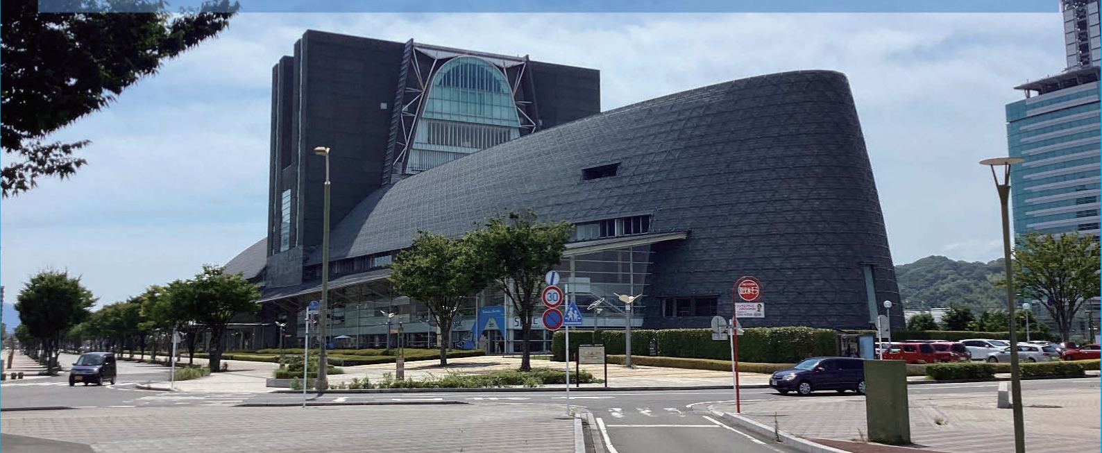
北東側のファサード
