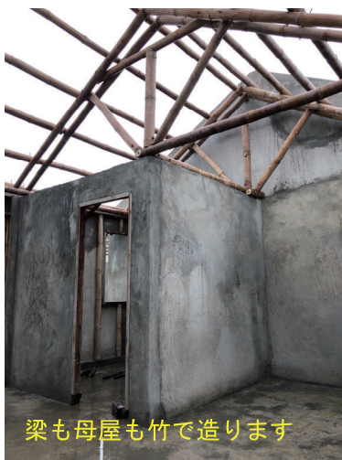
CFTならぬ CFB(セメント充填竹管構造)
